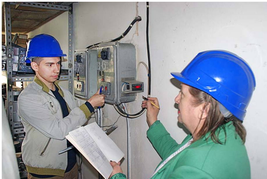
Специалисты бюро снимают показатели таймера пыле-, газоочистительного оборудования «Циклон»
